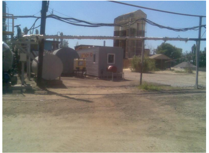
РФ. Воронеж. ООО «Дорога» Завод по производству битумной эмульсии с установкой «Катион-10» контейнерного типа.
