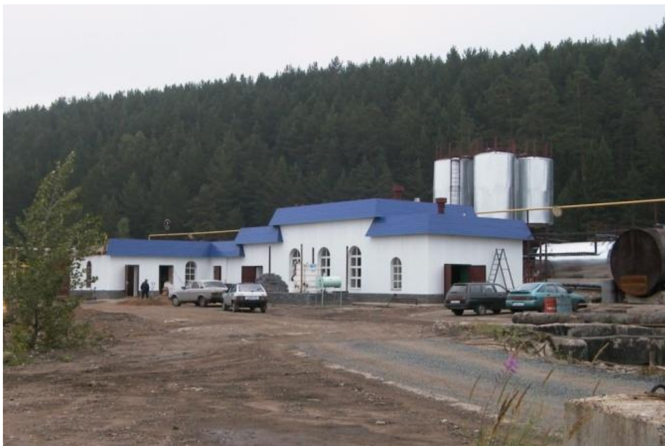
Татарстан, г. Набережные Челны, ОАО «Камдорстрой» Завод по производству битумной эмульсии с установкой «Катион-10» блочного типа.
